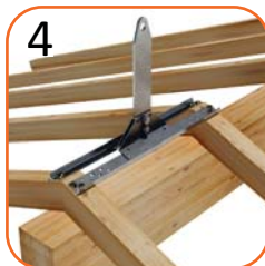
4 Travetti con interasse massimo 85 cm inclinazione 21° n°1 UNITH3/B n°1 KT90 n°8 VITLEG
